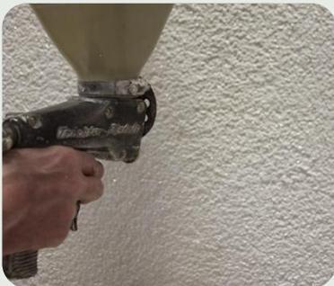
Den Glimmer maschinell mit Hilfe der alsecco Trichterpistole basic und einem geeigneten Kompressor unter geringem Luftdruck in den zweiten frischen Anstrich einblasen.
