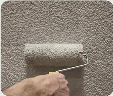
Den Putz nach Durchtrocknung mit einer Alsicolor Fassadenfarbe (accs 2225) in mindestens zwei Lagen beschichten.
