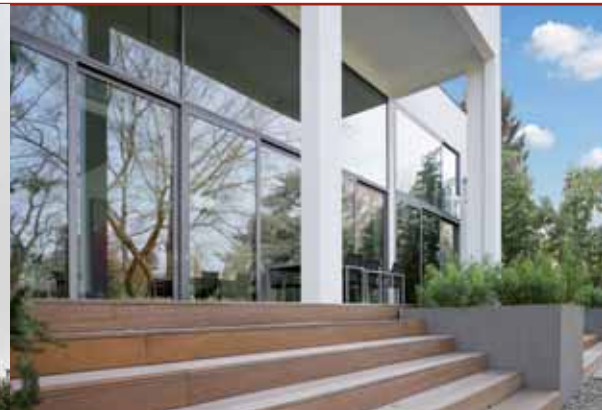
Durch das Fassadendämmsystem und die Dreifachverglasung der Fenster erfüllt das Gebäude den Niedrigenergiehausstandard.
