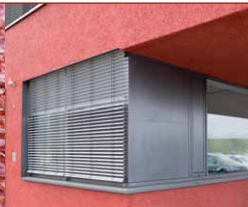
Die energieeffizienten Fenster mit Aluminiumrahmen haben eine dreifache Isolierverglasung.
