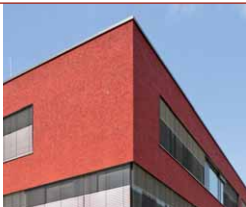
Die 260 Millimeter starke Polystyrol-Dämmung war ein entscheidender Faktor für die Realisierung des Passivhaus-Standards.
