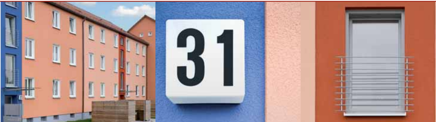
Neues, freundliches Entree: Über den Eingängen wurden neue Glasdächer montiert.
