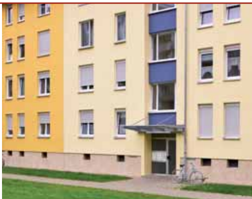
Im besonders belasteten Sockelbereich kam das widerstandsfähige Fassadensystem Spar Dash zum Einsatz. In der Fläche wurde die Fassade mit dem WDV-System basic gedämmt.
