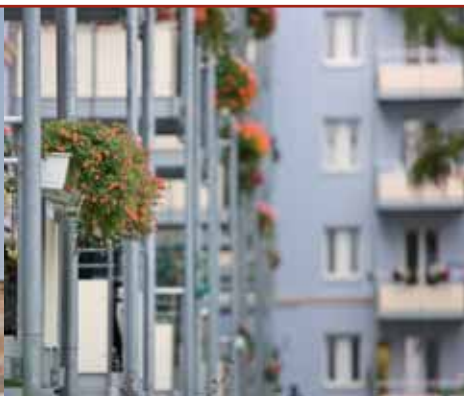
Mit einer Stahlkonstruktion vorgesezte Balkone waren ein weiterer Baustein der Sanierung.
