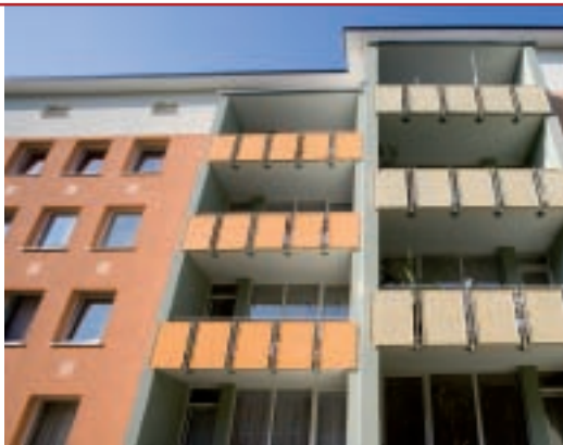
Optimal abgestimmt: Balkone und Fassade folgen einem durchdachten Farbkonzept.
