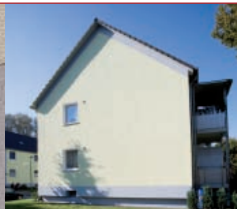
Harmonischer Kontrast: Der Sockelbereich wurde grau abgesetzt.
