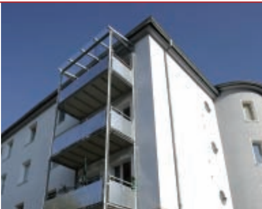
Vorgebaute Balkon-Konstruktionen schaffen völlig neue Ansichten.
