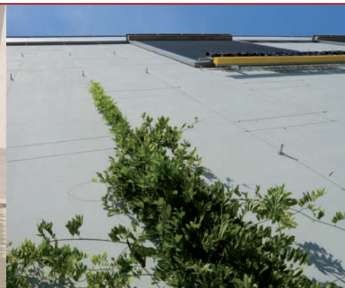
Die dezente graue Putzbeschichtung wurde mit dem Mineraleichtputz Alsilite F Aero ausgeführt.
