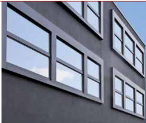
Die schwarze Putzfassade des Gebäudes wird durch horizontale Fensterbänder gegliedert.
