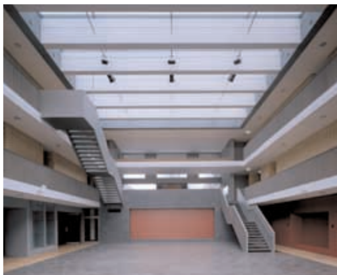
Zeitgemäß gedämmt: Der Wärmeverlust über die Außenwände hat sich nach der Sanierung um bis zu 70 Prozent reduziert.
