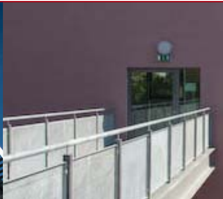
Die Putzfassaden wurden mit dem widerstandsfähigen alsecco Siliconharzputz ausgeführt.
