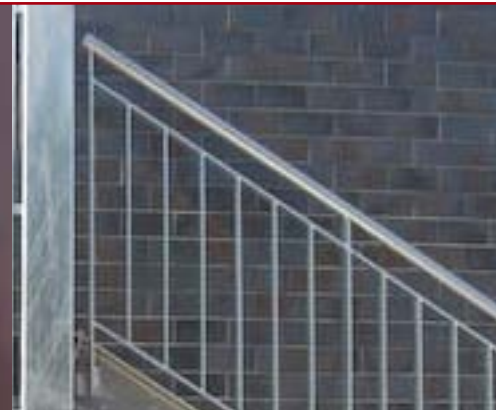
Perfekte Optik: Die eleganten Klinkerriemchen verklebten die Handwerker auf dem WDV-System.
