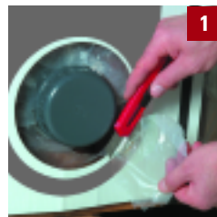
Öffnen der Schrumpfhülle am markierten Punkt
